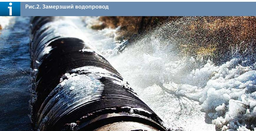
Рис.2. Замерзший водопровод
