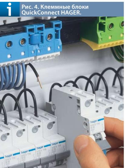
**Рис. 4. Клеммные блоки QuickConnect HAGER.**
