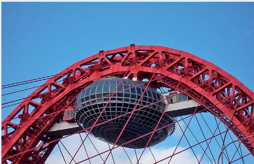
Несущие конструкции — пилон и ванты — окрашены в насыщенный красный цвет. Ванты представляют собой пучок из высокопрочных канатов (в зависимости от усилия в ванте, их количество составляет от 27 до 49 штук), заключенных в оболочку и имеющих внешний диаметр 130—300 мм и переменную длину от 40 до 196 метров. В узлах вант установлены амортизаторы для гашения ветровых вибраций.
