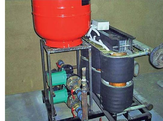
горячего водоснабжения (АСГВС) предназначены для решения задач горячего водоснабжения в жилых зданиях и предприятиях с небольшой потребностью в горячей воде. Они обладают всеми достоинствами индукционных нагревателей, имеют в своем составе: два контура нагрева (рис.5), что исключает влияние на электроннагреватель некачественной воды, аккумуляционную теплоизолированную емкость для сглаживания пиков водопотребления.
