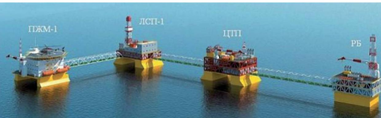
дения им. В.Филановского. Памятные доски были закреплены на закладных секциях платформ райзерного блока (РБ), жилого модуля (ПЖМ-1) и ледостойкой стационарной платформы №1 (ЛСП-1). ЛСП-1 предназначена для бурения и эксплуатации скважин. В состав платформы входят: буровой комплекс для бурения 11 наклонно-направленных скважин с горизонтальным заканчиванием ствола,
