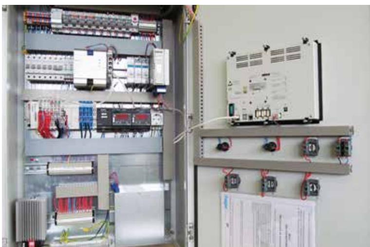
Рис. 1б. Шкаф управления для систем промышленного электрообогрева ТЕПЛОМАГ.
