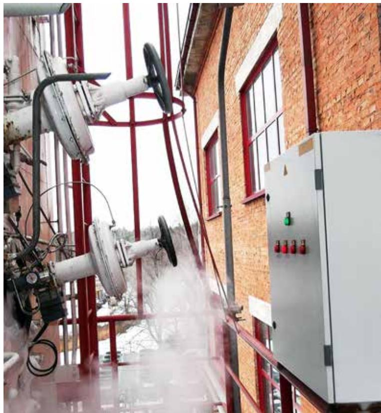
Рисунок 3. Общий вид электрощита блока управления нагревом.
