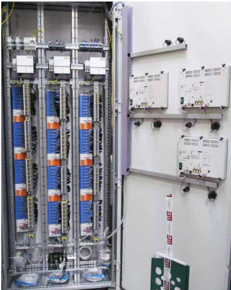
Рис. 1а. Шкаф управления для систем промышленного электрообогрева ТЕПЛОМАГ.
